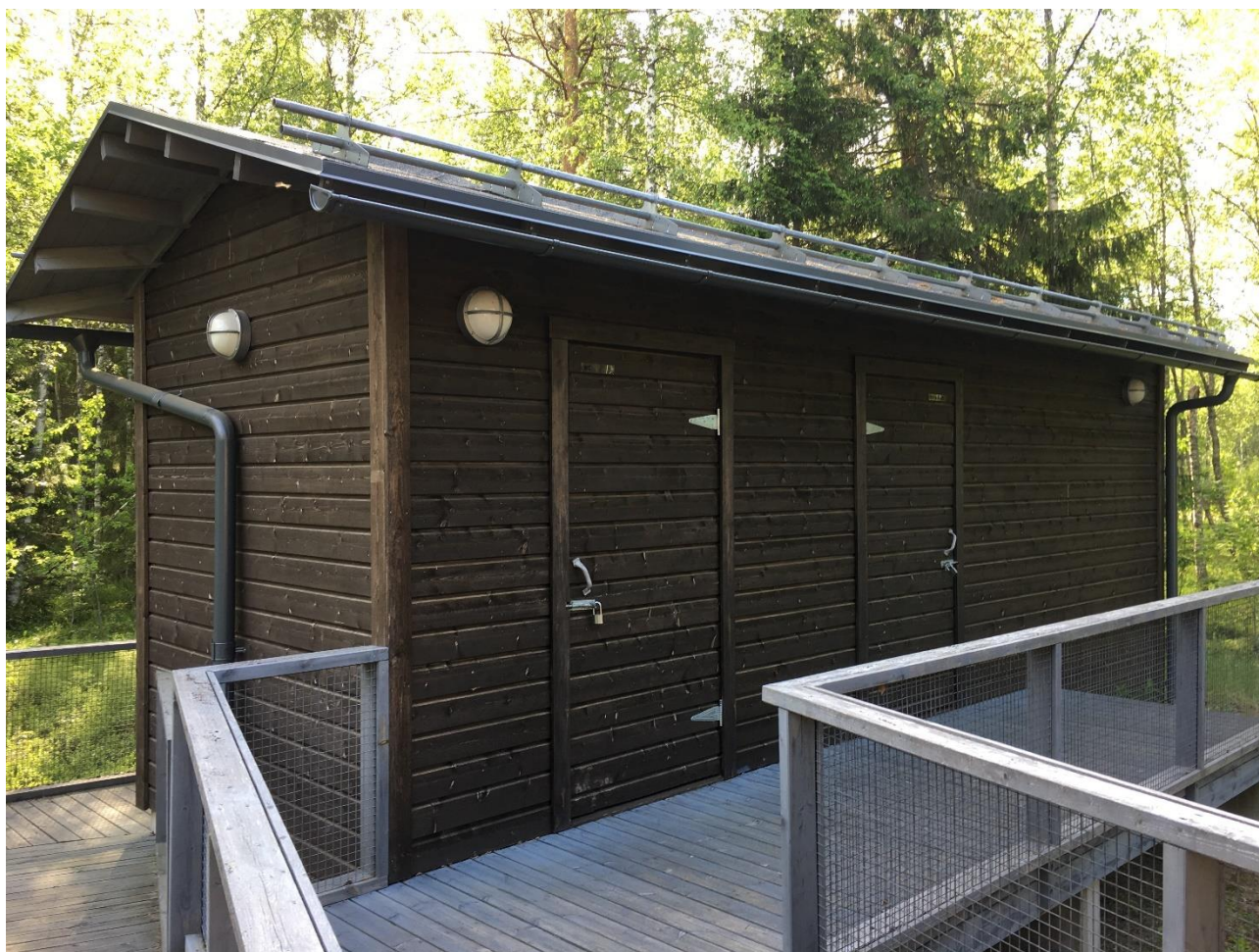
Huoltorakennus (puuvarasto, jätevarasto ja WC):
